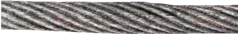
Rys. 13 Miejscowy wzrost średnicy liny spowodowany pogrubieniem się rdzenia włókiennego wskutek niszczących warunków zewnętrznych.
